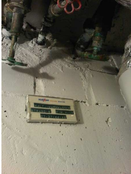
Foto 1 (Strang 6) Zugang über Technikraum
