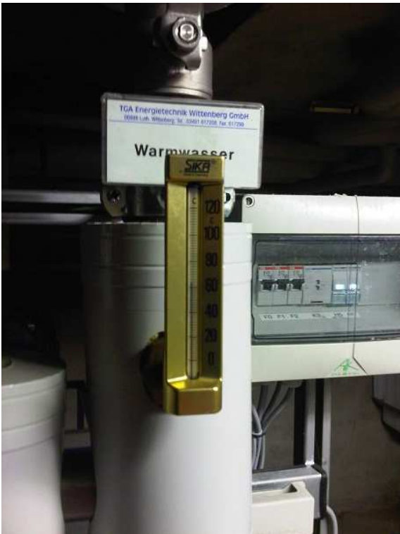
Foto 8 und 9 Anzeige Zirkulation und Warmwasseraustritt
