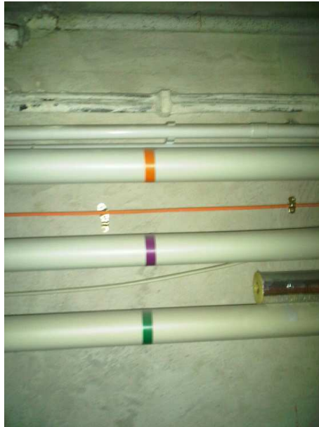
Foto 4 gekennzeichnete Trinkwasserleitungen
